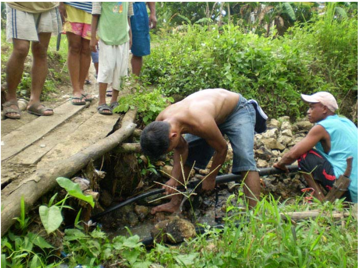
Die 3 km lange Leitung wird verlegt – März 2008
